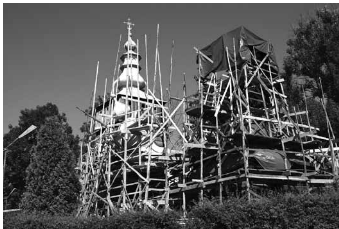
Cerkiew w Krempnej, 24 lipca 2007 r. zawalenie się kopuły środkowej w trakcie prac remontowych Fot. Katarzyna Hibner
